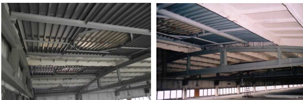
Rys. 19. Przykłady zmian konstrukcji połaci dachowych
