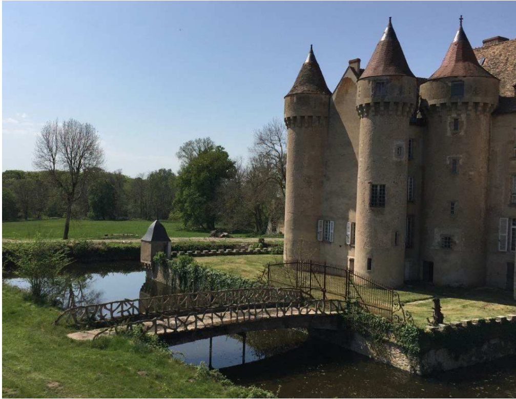
Rys. 13. Żelbetowy most Moniera przez fosę zamku Chazelet we Francji z 1875 r. [W3]
