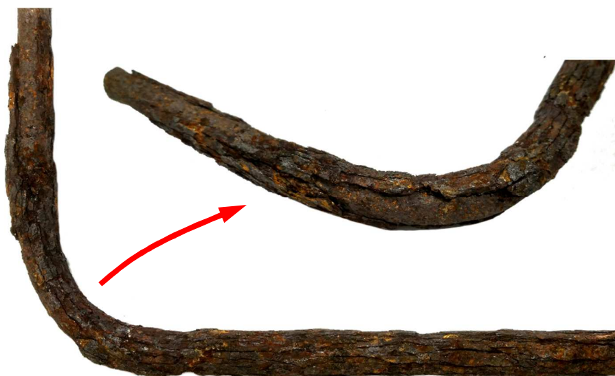
Rys. 3. Uszkodzona struktura pręta zbrojeniowego wynikająca z intensywnych procesów korozyjnych
