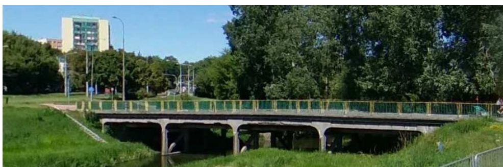
Rys. 18. Most nad rzeką Bystrzycą (pomiędzy al. Andersa a ul. Turystyczną), wybudowany w 1908 r przez Lutosławskiego [W4]
