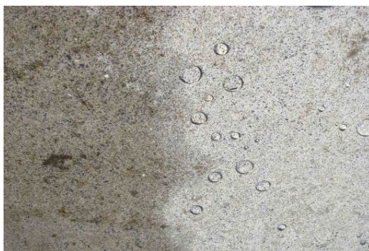
Rys. 8. Powierzchnia betonu po hydrofobizacji wykazuje zdolność do odpychania wody
