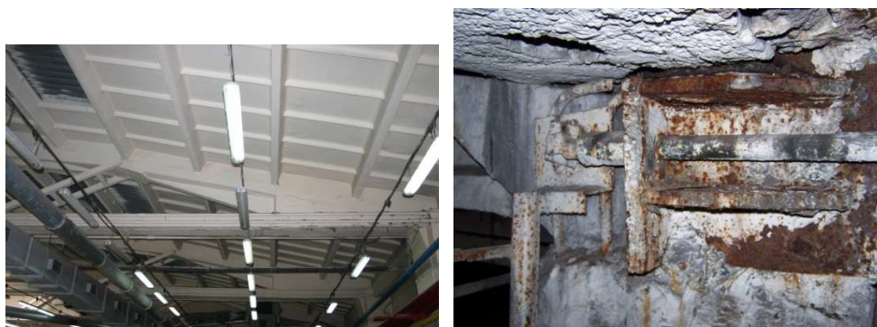
Rys. 38. Przykłady zewnętrznego sprzężenia istniejących dźwigarów kablobetonowych
