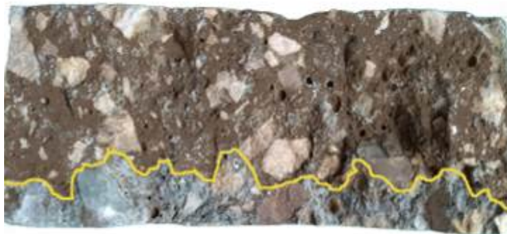
Rys. 16. Przełam próbki betonu po badaniu migracji po naniesieniu roztworu 0,1 M \text{AgNO}_3 . Żółtą krzywą zaznaczono głębokość, na którą wniknęły chlorki
