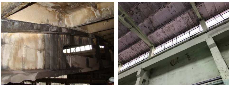
Rys. 20. Przykłady zalania konstrukcji dachowej wskutek nieszczelności pokrycia
