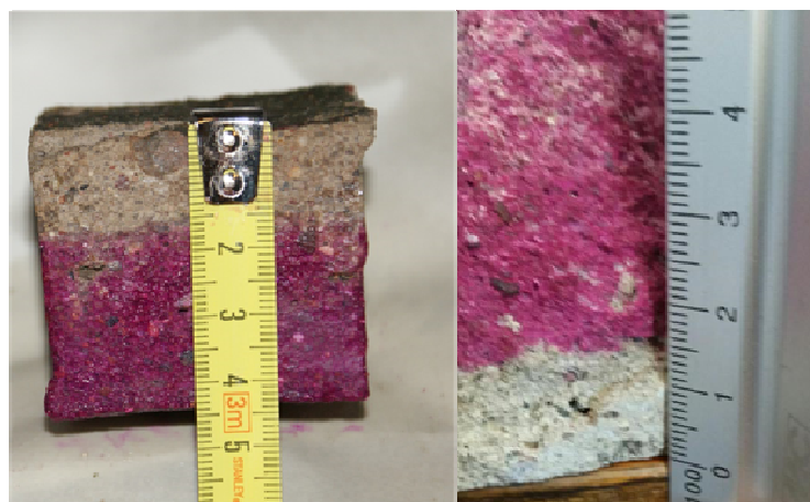
Rys. 40 Pomiar głębokości karbonatyzacji na odkuwce i fragmencie odwiertu
