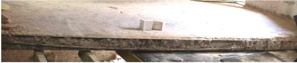
Rys. 15. Przykład stropu zbrojonego linami. Fotografia wykonana podczas jego rozbiórki
