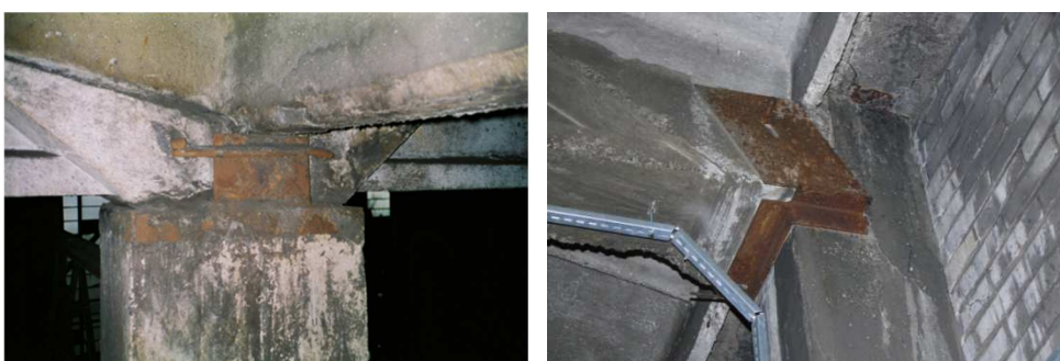
Rys. 15. Przykłady bezodpływowych przestrzeni wokół stref zakotwień
