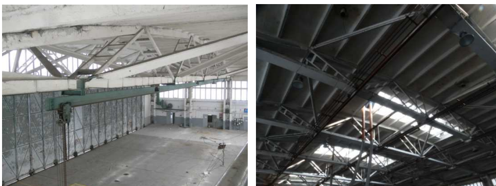
Rys. 17. Przykłady oryginalnych podwieszeń urządzeń transportowych
