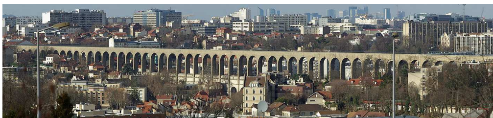
Rys. 10. Betonowy akwedukt de la Vanne wybudowany przez Coigneta w latach 1867-1874 [W6]
