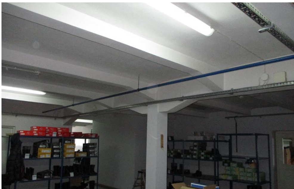
Rys. 17. Przykład stropu Hennebique'a. Muzeum Auschwitz
