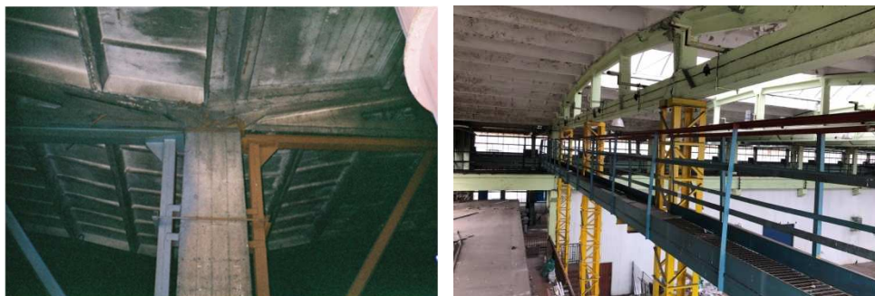
Rys. 37. Przykłady tymczasowych podparć dźwigarów kablobetonowych
