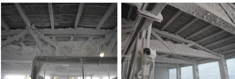
Rys. 18. Przykład obciążenia pyłem pasów dolnych dźwigarów
