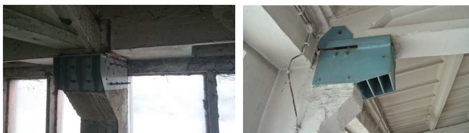
Rys. 36. Przykłady rozbudowy stref oparcia dźwigarów kablobetonowych
